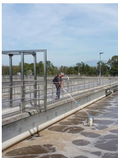
Slika 1. Odvzem vzorcev odpadnih plinov na gladini ozračevalnega bazena in zgoščevalnikih blata na čistilni napravi.
