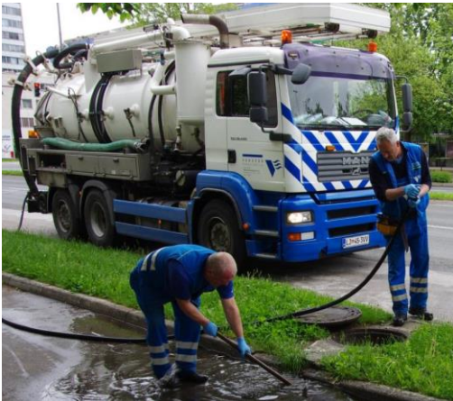
Slika 1: Strojno čiščenje cestnega požiralnika
