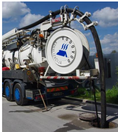
Slika 2 in 3: Strojno čiščenje kanalizacijskega omrežja in čistilna glava
