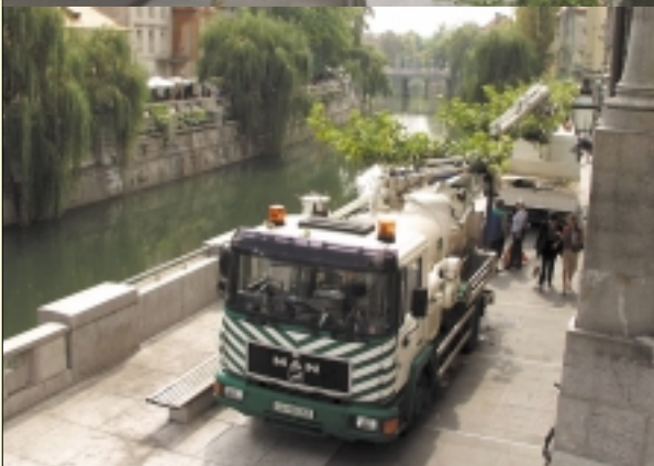
Ekipa, ki opravlja ročno čiščenje, se z lahкими tovornimi vozili pripelje do revizijskega jaška, skozi katerega delavci vstopajo v kanal.
