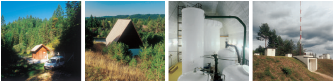
RAKITNA: 1 naselja Rakitna, Boršt, Jezero, Naklič, Novaki, Žotov grič, Stelnik 2 Brezovica 3 ca. 11000 m 4 filtracija na peščenih filtrih, ozoniranje, dezinfekcija s plinskim klorom 5 potok Podresnik oz. Žetovec 6 nelegalni priključki na sistem, potek javnega sistema oskrbe po lastniških parcelah 7 zamenjava skupinskih priključkov s posamičnimi, izgradnja novega sistema izven lastniških parcel, izgradnja prečrpalnice za zaselek Boršt (slike z leve proti desni; slika 1) Zajetje s črpališčem v dolini potoka Podresnik za vodovod Rakitna (slika 2) Objekt za pripravo vode na Rakitni (slika 3) Naprava za pripravo vode (slika 4) Vodohran na Rakitni
