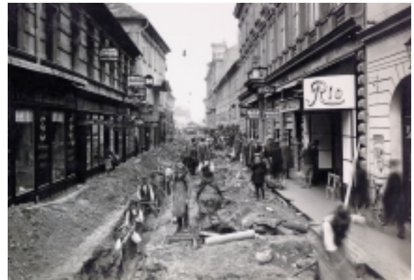
Gradnja vodovoda v Šelenburgovi ulici (danes Slovenska cesta) konec dvajsetih let 20. stoletja.
