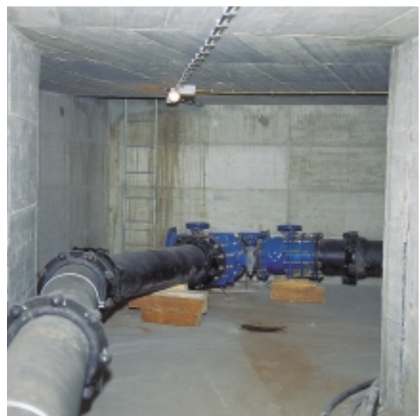
Kolektorji in komunalni vodi v njih so tehnično zelo primerna oblika, a žal mnogokrat ekonomsko neopravičljivi. Dokončanje vodovodov v kolektorjih na Dunajski in Vilharjevi bo zagotovilo varnejšo oskrbo z vodo.
