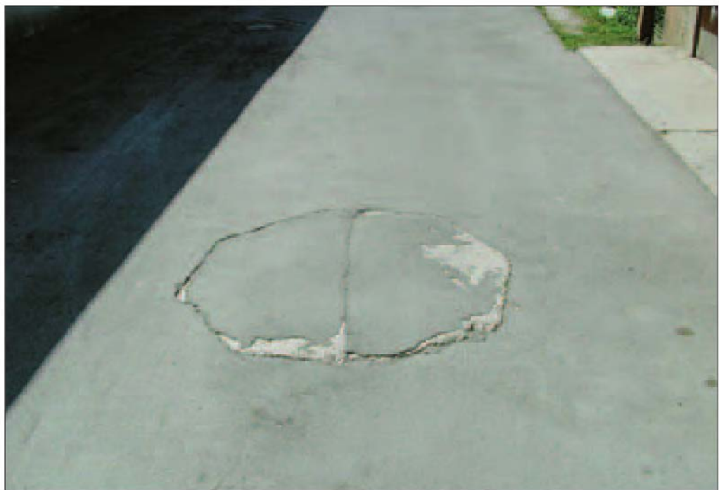
Slika 138: Več kot 500 vodnjakov je opuščenih, vendar niso zasuti, zato predstavljajo potencialno možnost za onesnaževanje.
