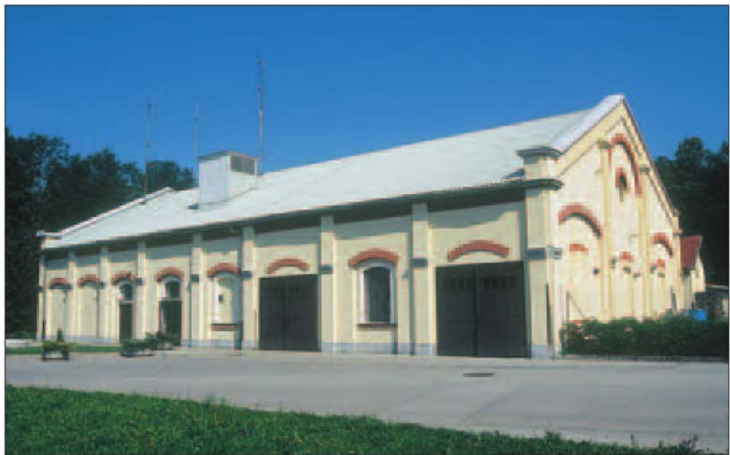
Slika 67: Upravna stavba vodarne Kleče iz leta 1890.
