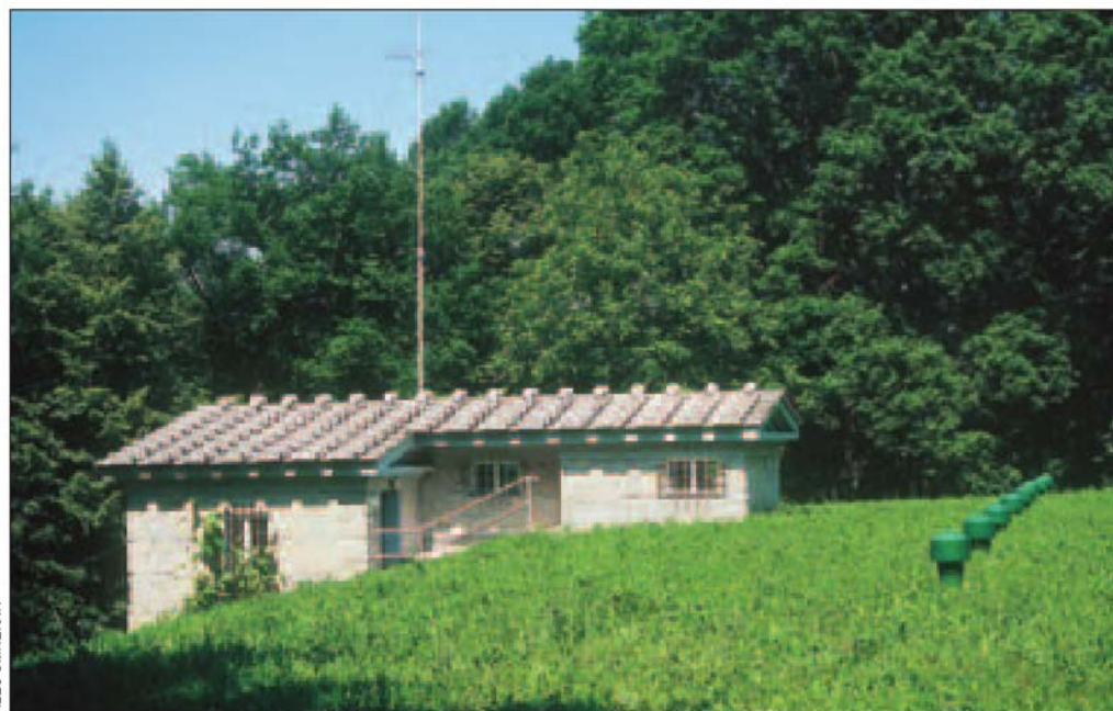
Slika 68: Rezervoarji na mestnih vzpetinah, kot je vodohran na Rožniku, opravljajo vlogo vodnih stolpov, ki jih poznamo iz drugih ravninskih območij.
