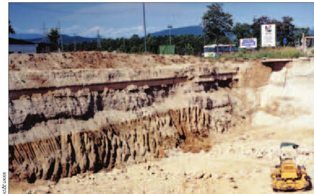
Slika 4: Vodonosnik sestavljajo plasti proda in konglomerata, ki jih krajevno ločujejo plasti gline.
