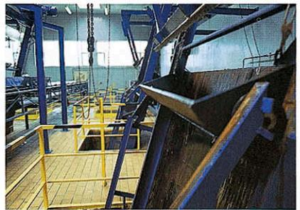
Fine grablje z napravo za avtomatsko čiščenje
