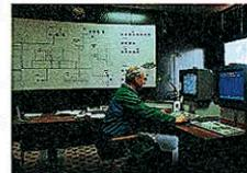
Dispēčerski center ljubljanskega vodovoda v Klečah omogoča neprekiniten nadzor nad obratovanjem in dajinsko upravljanje 43 vodnjakov, 2 prečrpvalnici, 3 vodo-hrane in druge naprave.
