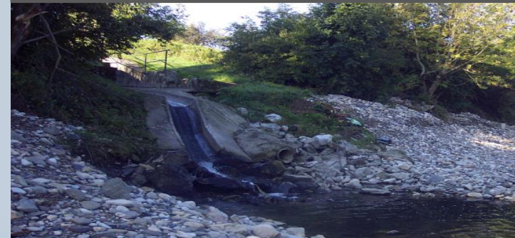
Iztok prečiščene odpadne vode iz ČN Brod
