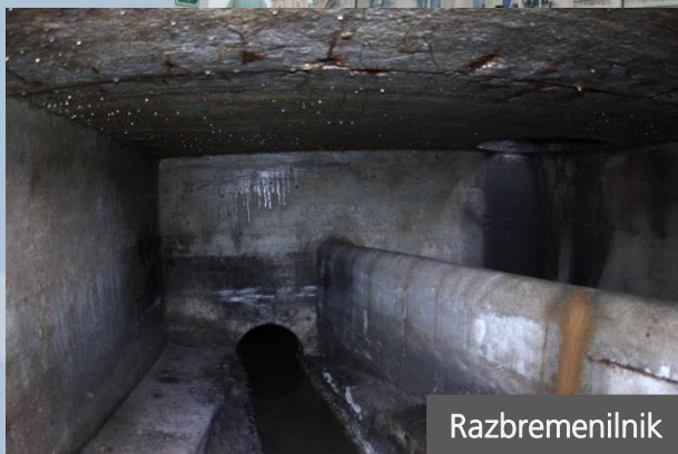
Razbremenilnik iz A-3 v A-4
