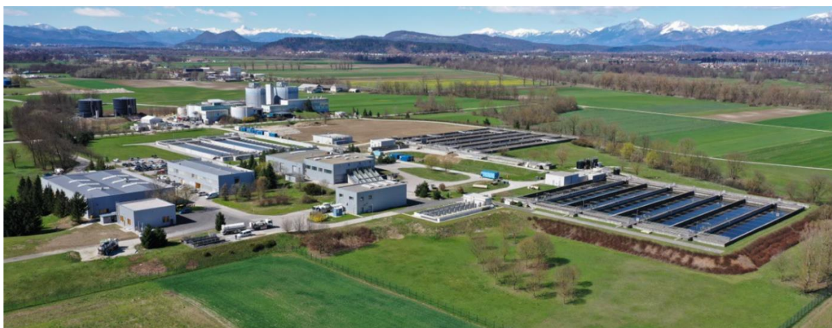
Centralna čistilna naprava Ljubljana
