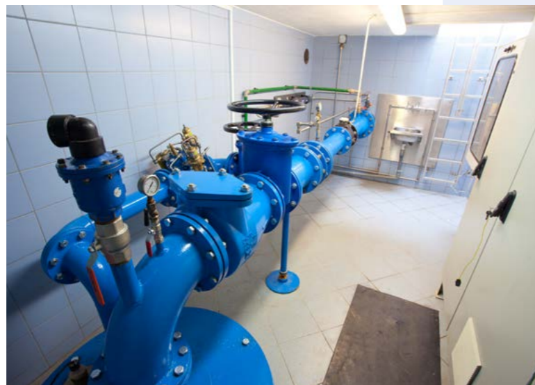
Notranjost vodnjaškega objekta
