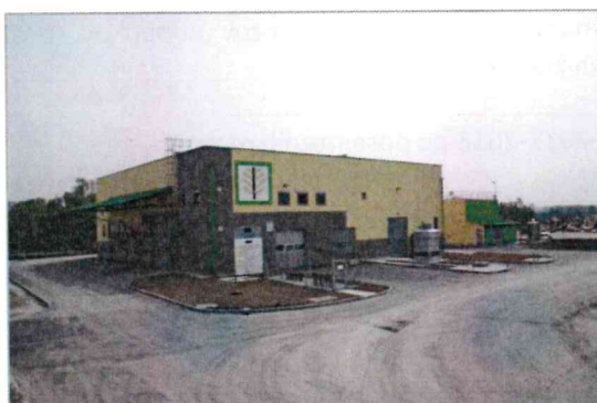
Slika 9: Čistilna naprava za izcedne vode
