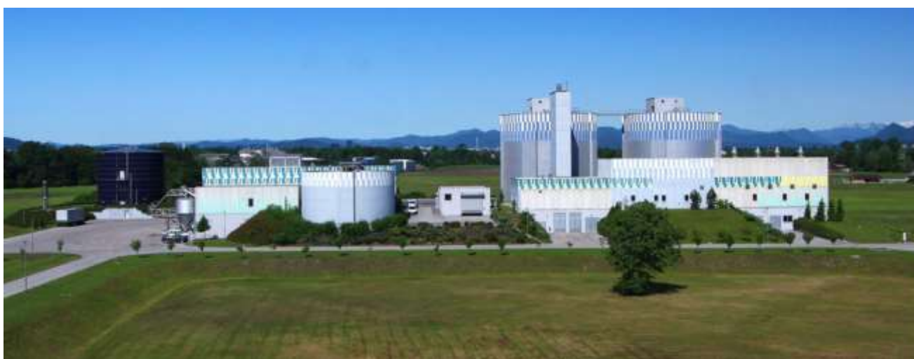
Objekti za obdelavo blata na Centralni čistilni napravi Ljubljana
